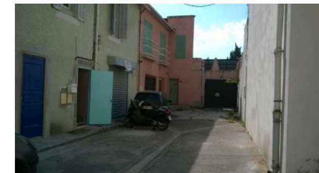
Façade sud impasse privée
