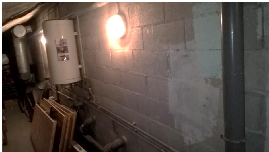
Local technique à RDC
